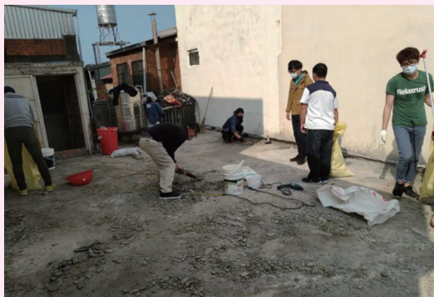
▲ 屋頂剔除工程
